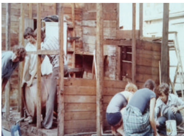
Des chantiers du Centre Sri Aurobindo entre 1974 et 1979.
